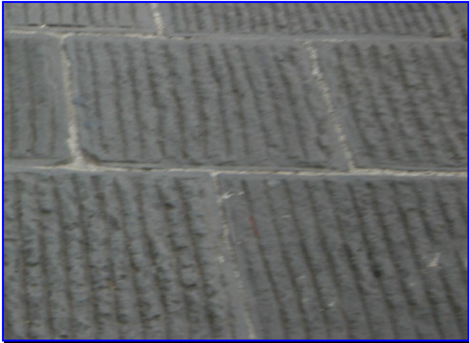
Figura 57 – 23 luglio 2009: marciapiedi in pietra
